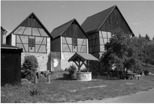
Mit wesentlicher Unterstützung des Arbeitskreises Heimatpflege Regierungsbezirk Karlsruhe gelang der Erhalt des Ensembles von Grüinkerndarren in Waldtürn-Altheim.
