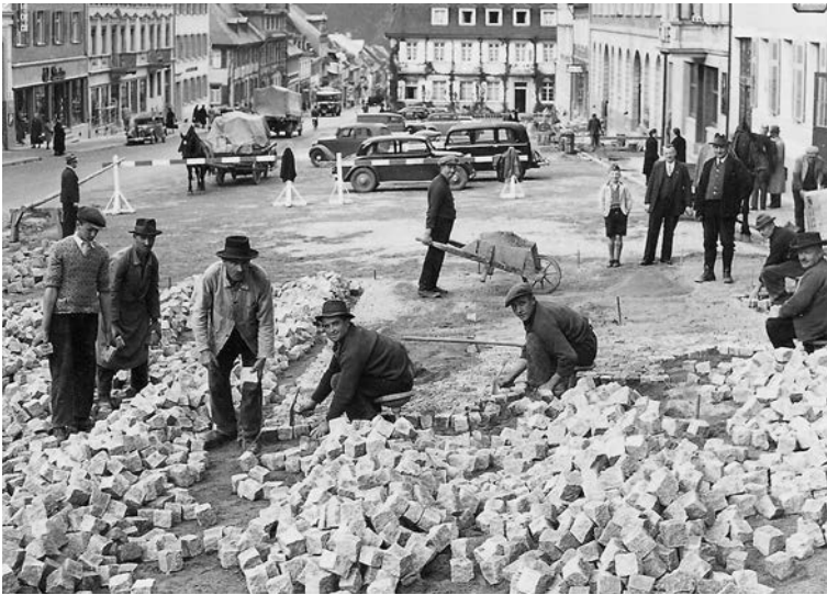
Abb. 7: Beim Bau der Straßen gab es damals noch viel Handarbeit. Diese gestochen scharfe, historische Aufnahme von Mitte der 1930er Jahre mit herrlich anzuschauenden Kraftfahrzeugen im Hintergrund zeigt den Bau der heutigen Bundesstraße 500 vor dem Rathaus in Triberg. Straßen und Plätze wurden damals bevorzugt aus Pflastersteinen hergestellt.
