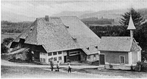
Abb. 12: Jockeleshof in Hinterzarten, Hauptgebäude erbaut 1704 (Typ: Höhenhaus/Heidenhaus, zweigeschossiger Wohnteil bergseitig) – Foto um 1900.
