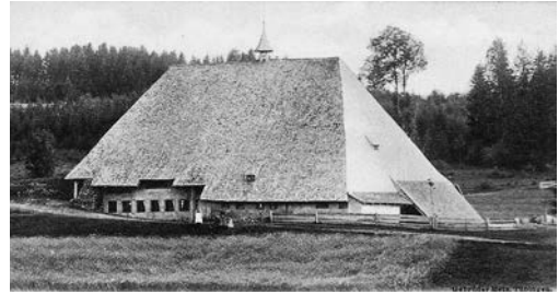
Abb. 13: Untergeschwendhof in Neukirch bei Gutenbach, erbaut um 1650 und 1730 bergseitig erweitert (Typ: Höhenhaus/Heidenhaus, zweigeschossiger Wohnteil bergseitig) – Foto um 1900.
