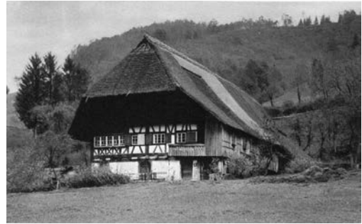
Abb. 10: Fegershof vor Gelbach in Oberwolfach, erbaut 1718 (Typ: Kinzigtäler Haus, eingeschossig, über gemauertem Sockelgeschoss fürs Vieh, zweiraumbreiter Wohnteil) – Foto um 1910.
