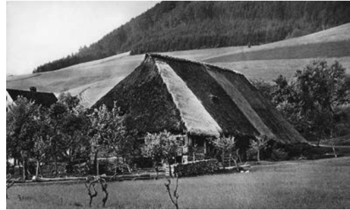
Abb. 16: Flammhof in Glottertal, erbaut 1713 (Typ: Dreisamtäler Haus, im Bild nicht sichtbar: Wandvorsprung an rechter Frontseite, äußerer Gang führt von Frontseite längs bis zu den Gesindekammern über dem Stall). Links im Bild das Dach des im 19. Jahrhundert errichteten steinernen Wohnhauses. Das unter Denkmalschutz stehende historische Holzhaus wurde fortan nur noch als Stall und Leibgedingwohnung genutzt – Foto um 1920.
