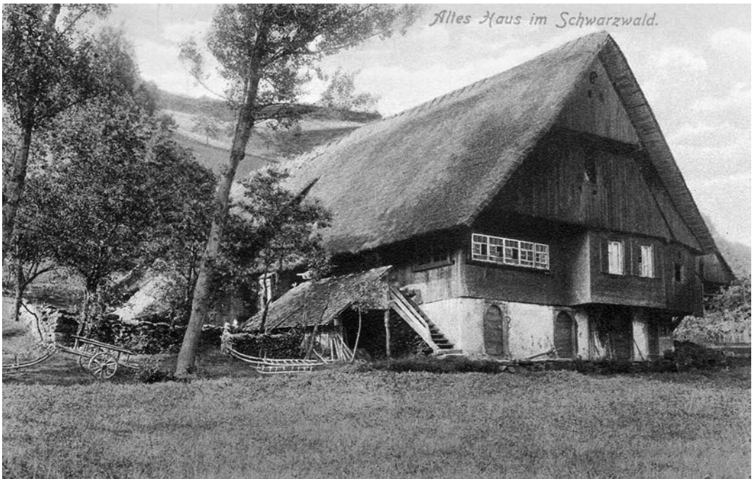
Abb. 11: Zangershof in Oberwolfach, erbaut um 1700 (Typ: Kinzigtälner Haus, eingeschossig, über gemauertem Sockelgeschoss fürs Vieh, zweiraumbreiter Wohnteil) – Foto um 1900.
