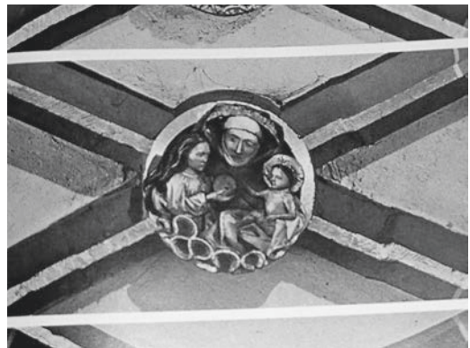
Abb. 1: »St.-Anna-Schlussstein« im gotischen Kreuzrippengewölbe der St. Martinskirche in Staufen, Foto von L. Geiges, a.a.O., S. 113
