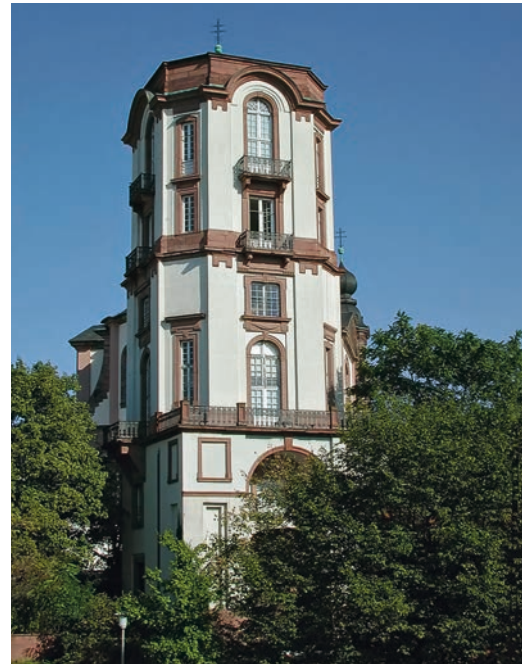
Die Sternwarte nach den Renovierungsarbeiten 1976.
