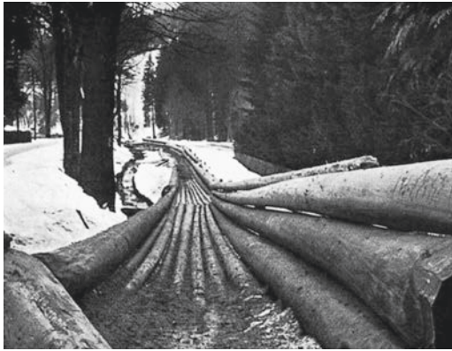
Abb. 2: Aus Baumstämmen errichtete sogenannte »Riese« (Holzrutsche – gelegentlich bis zu 5 km lang), in der man die gefällten Baumstämme schleifte, die dann durch ihr Eigengewicht mit hohem Tempo zum Lagerplatz ins Tal glitten.
