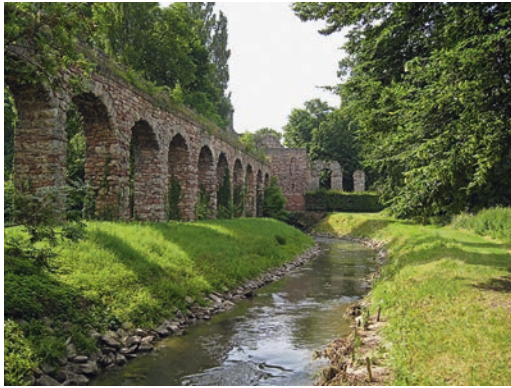
Leimbach am Schwetzinger Schlossgarten, Aquädukt. Foto: U. Heidenreich
