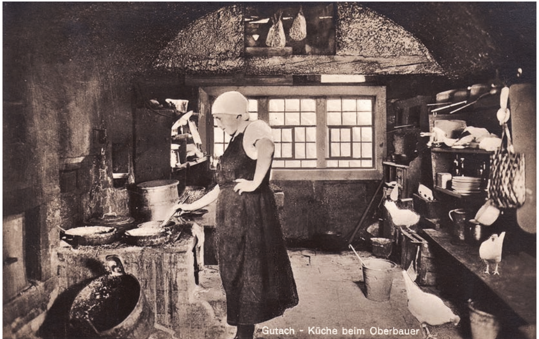
Abb. 5a: Rauchküche des Oberbauernhofs (Abb. 5) um 1930. Hinter der Öffnung des Rauchfangs (Gwölms) sind die dort zum Räuchern aufgehängten Fleischvorräte zu erkennen.
