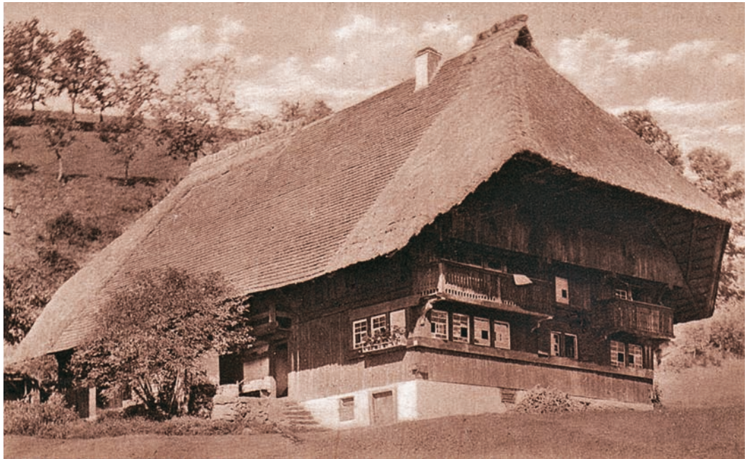
Abb. 6: Der wahrscheinlich um 1880 erbaute Vorderschlauchbauernhof in Gutach/Schwarzwaldbahn um 1910. Das Foto belegt, dass es die in Schillis Standardwerk (1953) zeichnerisch dargestellte Fachwerkwand in der Giebelseite dieses Hauses nicht gab. Mit der Fachwerkwand (vgl. Abbildungen 1, 3 und 5) wollte Schilli offenbar andeuten, dass sich hinter ihr die Rauchküche befindet. Tatsächlich aber ist die Küche dieses Hauses gegenüber dem Hauseingang an der rechten Traufseite angeordnet.
