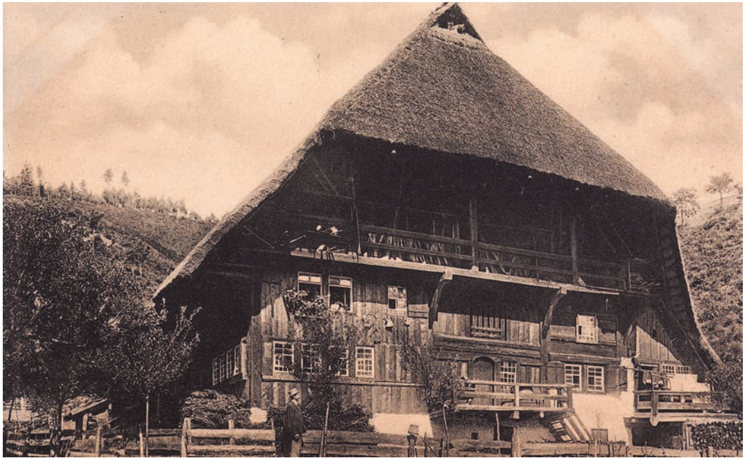
Abb. 7: Giebelansicht des um 1680 erbauten und 1914 abgebrannten Hinterschlauchbauernhofs in Gutach/Schwarzwaldbahn um 1900 – ein zweigeschossiges Gutachtäler Haus (siehe auch Abb. 7a). Die Außenwand der Rauchküche, etwa in der Mitte der Frontseite, besteht offensichtlich aus Holzbohlen. Oberhalb der Küche am vorgelagerten äußeren Küchenzugang ist das Rauchgatter zu erkennen, durch das der wesentliche Teil des Rauchs vom Küchenherd und Kachelofen der Stube, der von der Küche beheizt wurde, ins Freie abzog. Der restliche Rauch gelangte über den Dachraum ins Freie.
