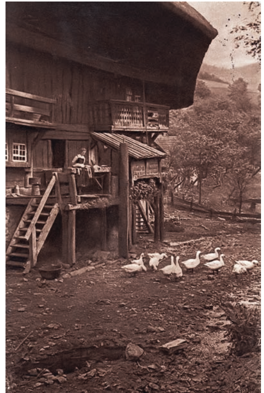
Abb. 8: Offensichtlich ähnlich dem Hinterschlauchbauernhof (Abbildungen 7 und 7a) bestand auch beim höchstwahrscheinlich vor 1722 erbauten Bürlebauernhof in Gutach/Schwarzwaldbahn die Außenwand der Rauchküche ausschließlich aus Holzbohlen – d. h., auch an diesem Gutachtäler Haus gab es keine Fachwerkwand, Foto um 1910. Oberhalb der Küchenaußentür – auf dem Podest mit Milchhäusle – sind die Aussparungen in der hölzernen Außenwand zu erkennen, durch die der Rauch ins Freie abzog.
