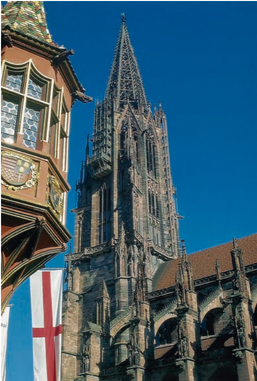
Erker des Historischen Kaufhauses (ca. 1530) und hochgotischer Turm des Freiburger Münsters.
