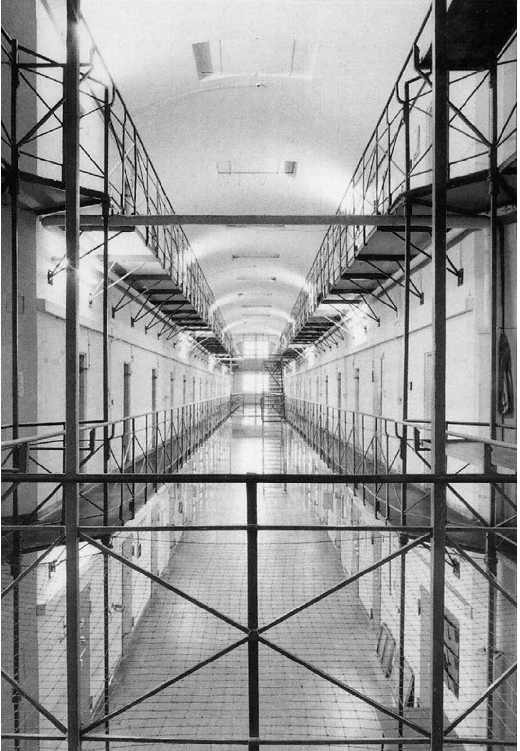
Zuchthaus Bruchsal: Blick vom Zentralbau in einen der Zellenbauten
