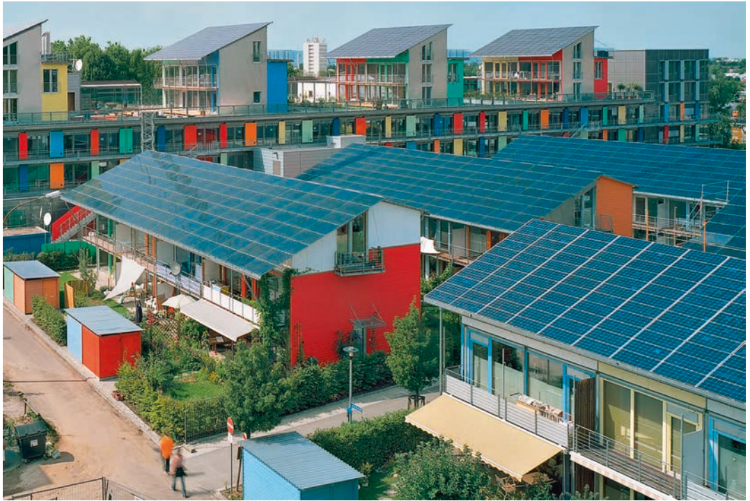
Plusenergiehäuser in der Solarsiedlung in Vauban – im Hintergrund das Sonnenschiff an der Merzhäuser Allee
