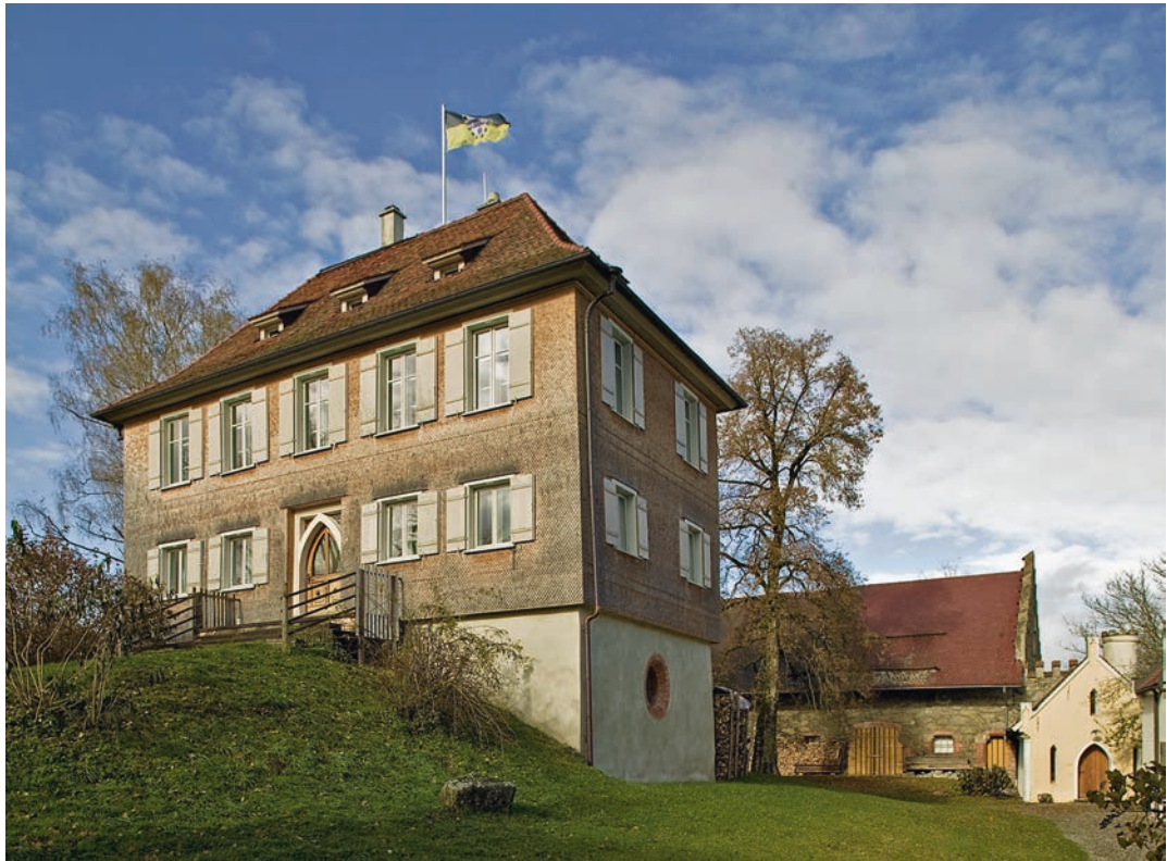
Die Südseite des Schlässchens mit seiner Fassade von 1816 und der das Sockelgeschoss überwindenden Rampe.
