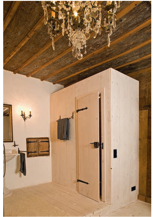
Kontrast von Alt und Neu: additiv eingestellte Toilette im Badezimmer.
