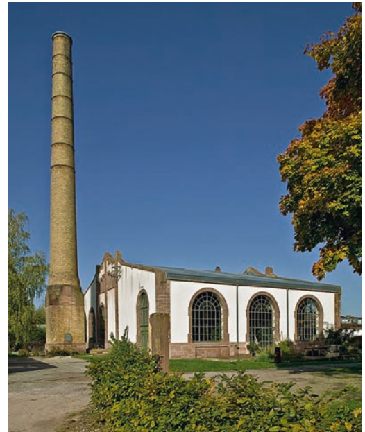
Zu Wohnzwecken umgenutzt: das ehemalige Heiz- und Maschinenhaus der Heil- und Pflgeanstalt Illenau in Achern.
