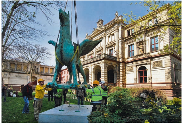
Der Greif wird im Garten des Stadtmuseums installiert. (Foto: Müller-Gmelin)
