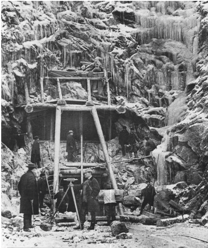
Gerwig am Nivelliergerät auf der Triberger Tunnelbaustelle, November 1868 (Foto: Carle, Triberg)
