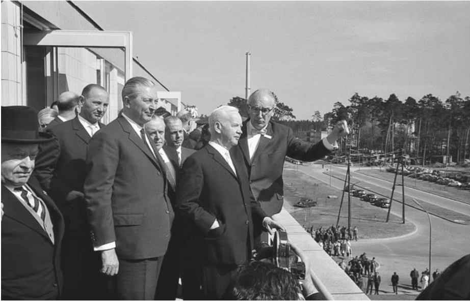
Heinrich Lübke (Mitte) mit dem Vorsitzenden der Kernreaktor-Bau- und Betriebs-GmbH, Gerhard Ritter (rechts) und Kurt Georg Kiesinger auf dem Balkon eines Institutsgebäudes des Kernforschungszentrums Karlsruhe, 7. April 1960 (Stadtarchiv Karlsruhe 8/BA Schlesiger A7_49_3_33)
