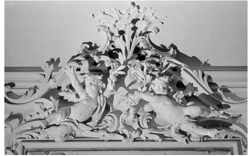
Die schönsten Stukkaturen hat Albucci in den für den Kurfürsten bestimmten Räumen des ersten Turmgeschosses und in den der Kurfürstin gewidmeten Räumen des zweiten Stockwerks im Obertor geschaffen
