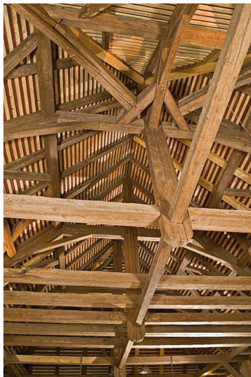
Der Blick in das Dachwerk zeigt die Qualität der Zimmermannsarbeit des 18. Jahrhunderts
