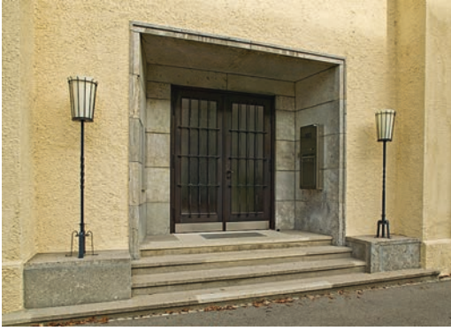
Der repräsentative Hauptzugang aus den 1930er Jahren Bildnachweis: alle Aufnahmen Bernd Hausner, Landesamt für Denkmalpflege
