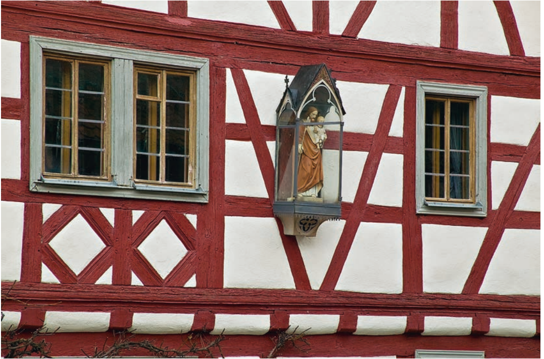
Der Heilige Josef mit dem Jesuskind am preisgekrönten Fachwerkhaus in Kilsheim war spurlos verschwunden. Heute ist er nach der vorbildlichen Haussanierung wieder in sein Schutzhäuschen an der Giebelseite zurückgekehrt
