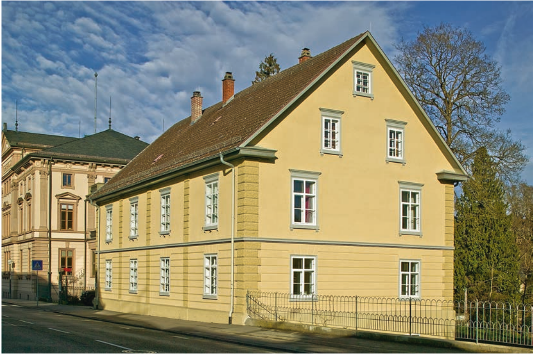
Das Beamtenwohnhaus in der Sigmaringer Karlstraße mit ihrer Bebauung des 19. Jahrhunderts
