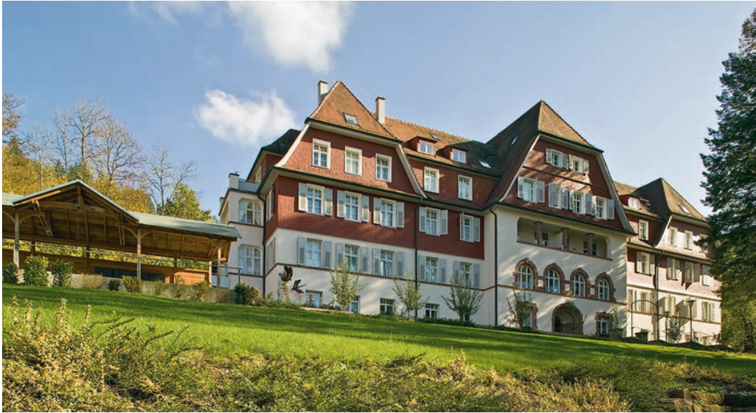
Tief heruntergezogene Dächer und die Teilverschindelung lassen das ehemalige Erholungsheim in Bad Liebenzell kleiner erscheinen als es tatsächlich ist. Nichts verrät außen die Umnutzung in Wohnungen
