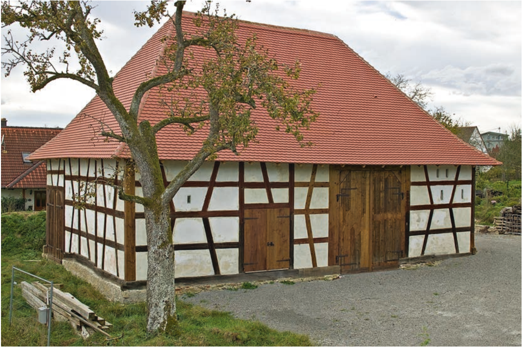
Auch nach der Sanierung hat sich der Charakter des Torkels als landwirtschaftliches Gebäude ohne Einbußen erhalten.
