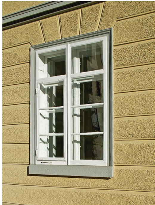
Die historischen Fenster wurden bewahrt und bieten dank der Vorfenster eine ausreichende Wärmedämmung
