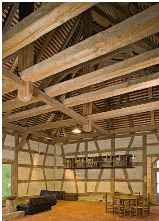
Durch den Verzicht auf einen Ausbau blieb der großartige Raumeindruck des Torkels erhalten
