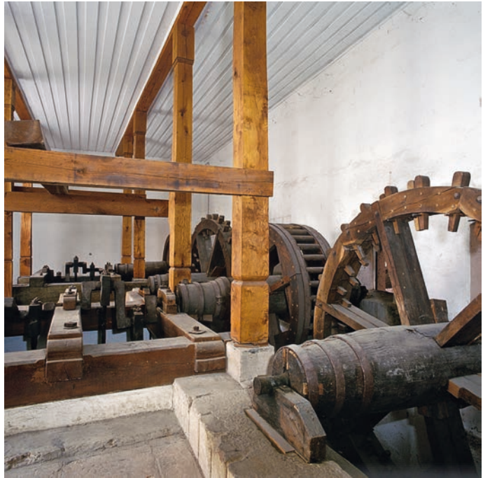
Technisches Denkmal Oberes Wasserwerk mit der originalen Einrichtung von Thomas und Johann Breuer aus dem 18. Jahrhundert (Foto: Steffen Hauswirth, LMZ302508)
