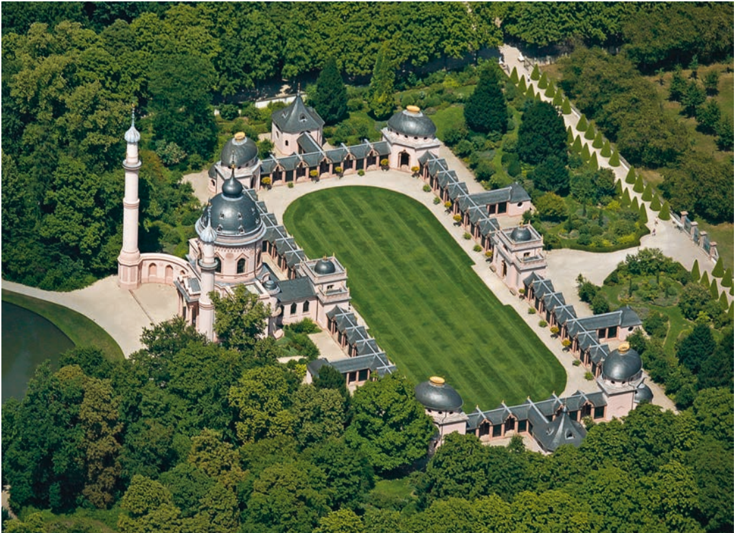
Moschee. Nicolas de Pigage verarbeitete Anleihen u. a. aus Johann Bernhard Fischer von Erlachs Entwurff Einer Historischen Architectur (Mekkaprojekt, Karlskirche) und dem Stichwerk von William Chambers zu Kew Gardens (England) zu einer eigenständigen und monumentalen Lösung (Foto: Bauamt Schwetzingen)
