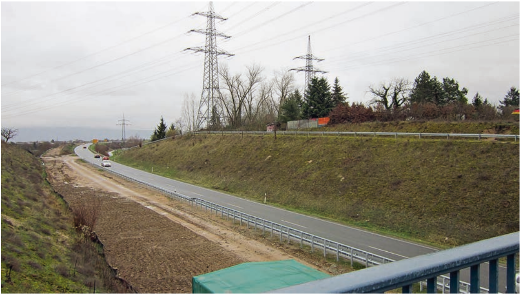
»Wingertsbuckel«, östliche Gemarkung, südlich der Tompkins Barracks im Querschnitt, entlang der B 535
