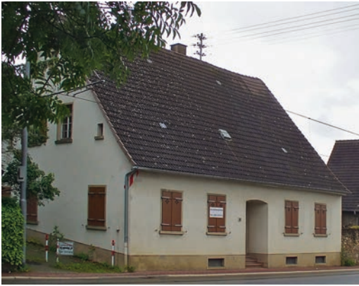
Das ehemalige Zollhaus in Großsachsen 2013
