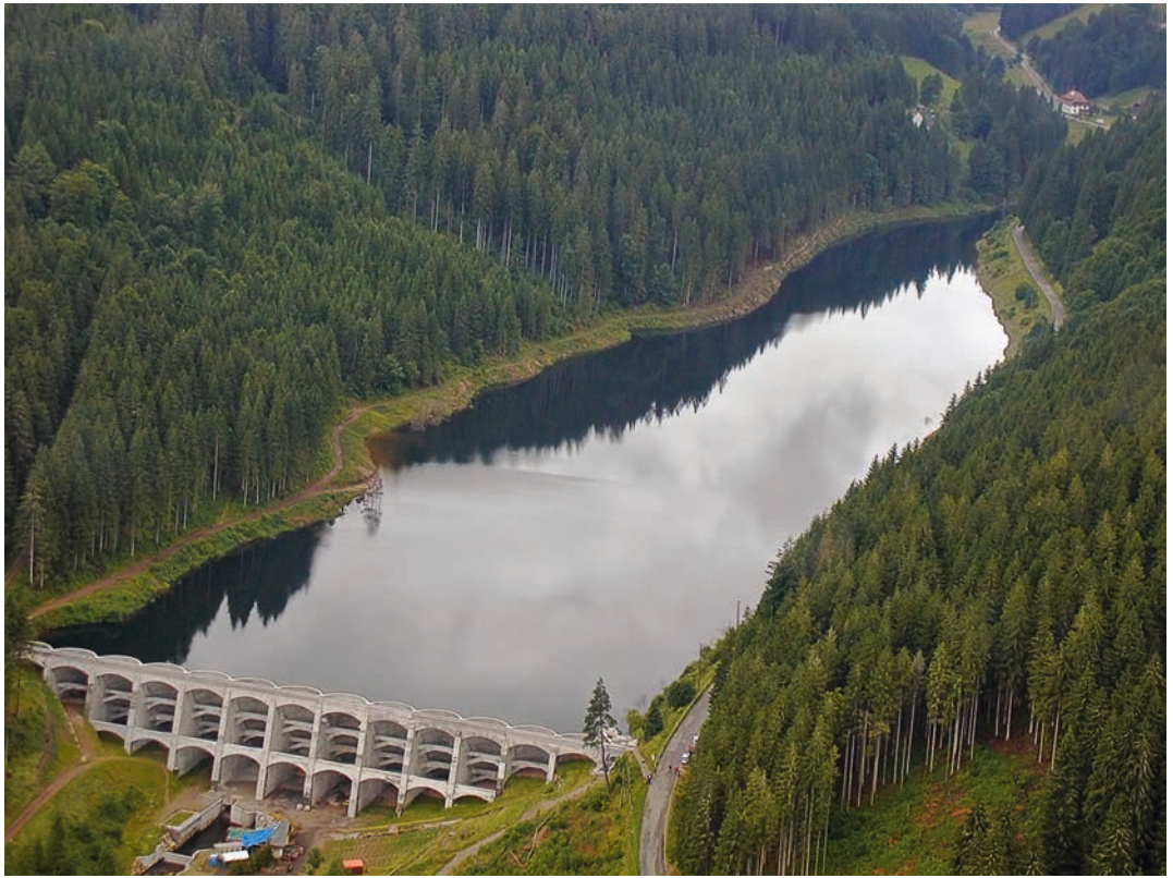
Das Kraftwerk während der Reaktivierungsarbeiten (Foto. W. Dold)
