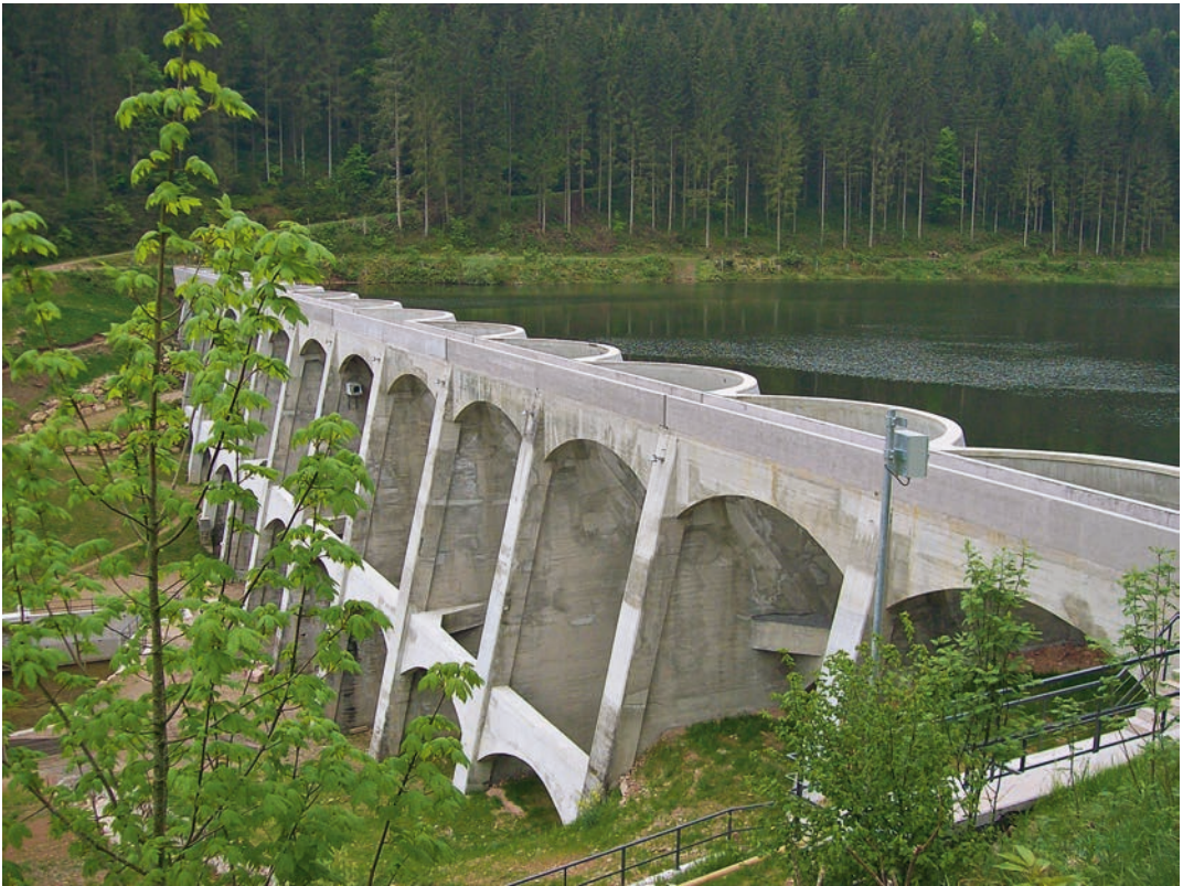
Die dreizehnbogige Gewölbereihenmauer der Linachtalsperre ist bis heute einzigartig in Deutschland (Foto: W. Dold)
