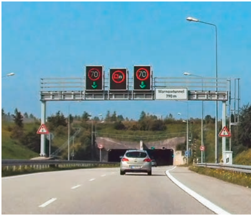
Einfahrt in den Warnow-Tunnel bei Rostock in Mecklenburg-Vorpommern, dem ersten privat finanzierten Fernstraßenbauprojekt Deutschlands: 3,50 Euro in bar kostet es im Sommer für einen PKW, diese Straßenabkürzung unter der Warnow kurz vor der Mündung in die Ostsee hindurch zu benutzen, im Winter 2,80 Euro
