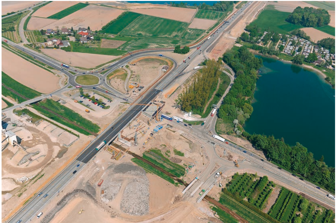
Vier Anschlussstellen mussten angepasst bzw. total umgebaut werden, hier ein Blick auf das Bau-Gewühle bei der Anschlussstelle Achern. Links der Autobahn ist bereits einer der beiden neuen »Brillenkreisel« zu erkennen
