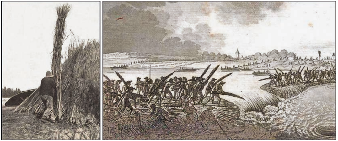
Abb. 6: Faschinenherstellung Einbau von Faschinen in Dämme (Fleig, 1933, S. 135; Eytelwein 1800, S. 3)
