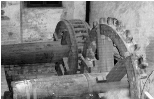
Bild 4: Zahnrad-Übersetzung des Hebewerks im „Unteren Wasserwerk“
