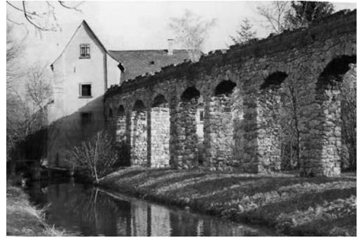
Bild 3: „Unteres Wasserwerk“ Heutige Ansicht mit den Bögen der „Römischen Wasser- leitung“ 1
