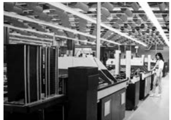
Abb. 9: Automatische Leiterplattenbestückung November 1982.
