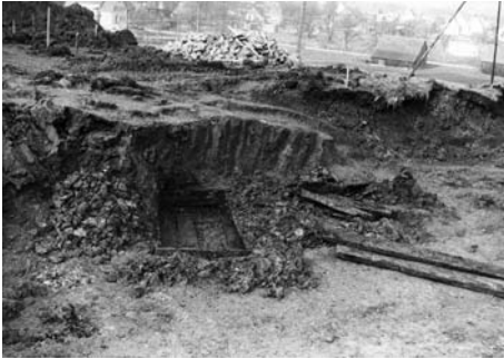
Abb. 3: Hüfingen „Gierhalde“. Baugrube mit den Resten von Kammergrab 1 nach Einstellung der Baggerarbeiten (Aufnahme: Archivar G. Goerlipp).
