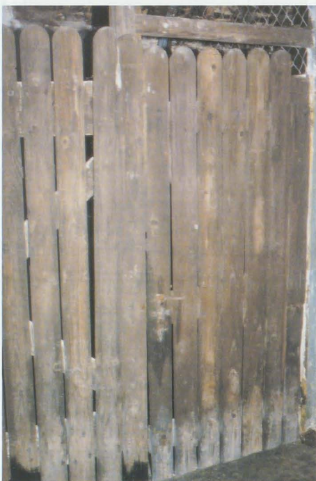
Teilstück des hölzernen Eingangstores dient heute als Heizöltank-Absperrung.
