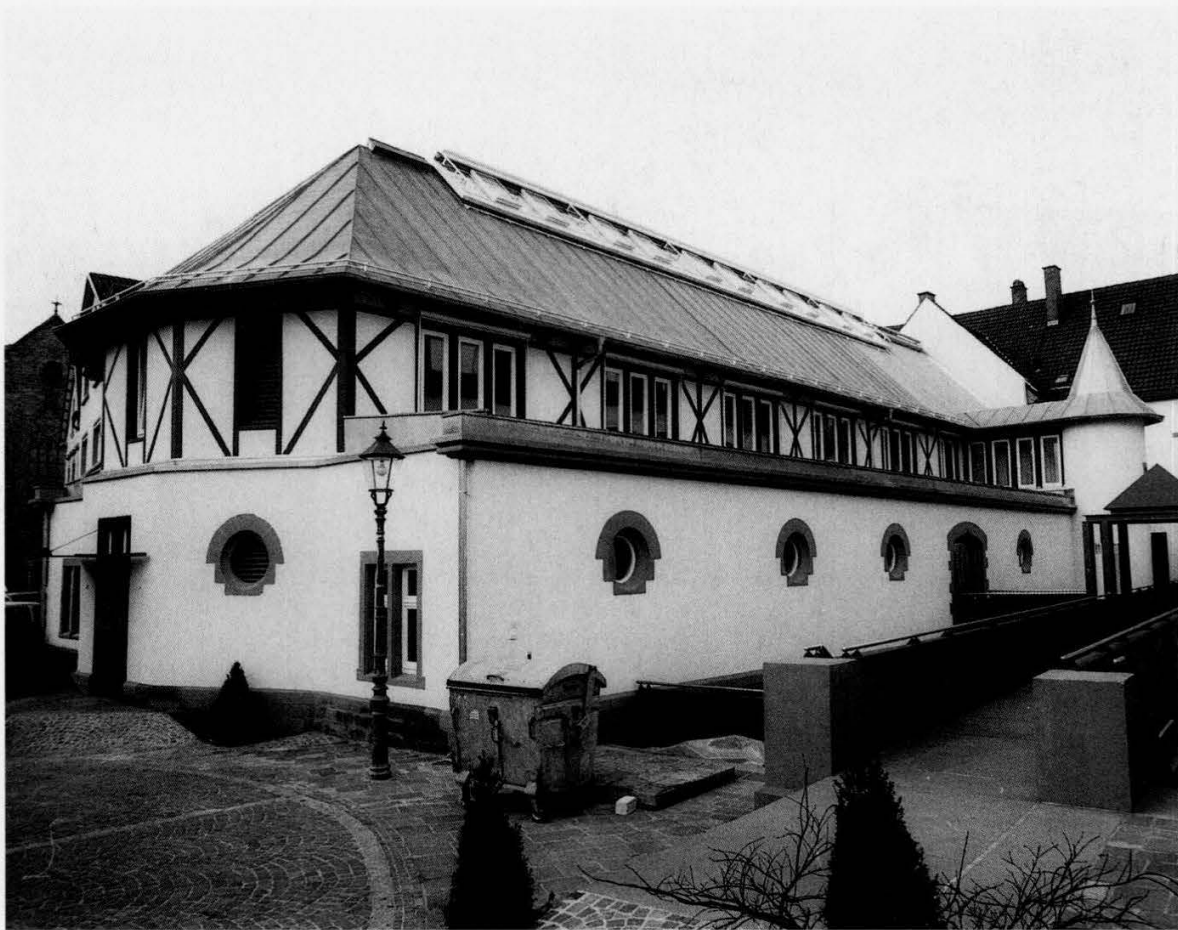
Außenansicht des Friedrichsbaus in Bühl, von der Franz-Conrad-Straße gesehen: Die basilikale Querschnittform des FestsaaIs ist deutlich erkennbar.
