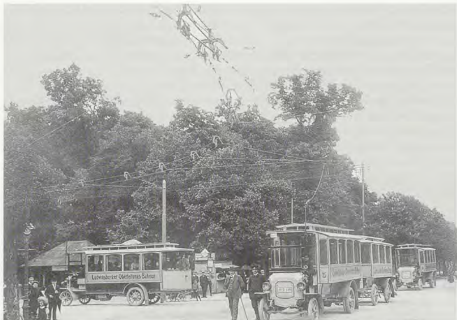
Am »Schwätzbänkle« an der Ecke Wilhelm-/Schlossstraße zweigte die Linie zum Heilbad Hoheneck ab. Zu diesem Zweck erhielt die Oberleitung eine Weiche.
