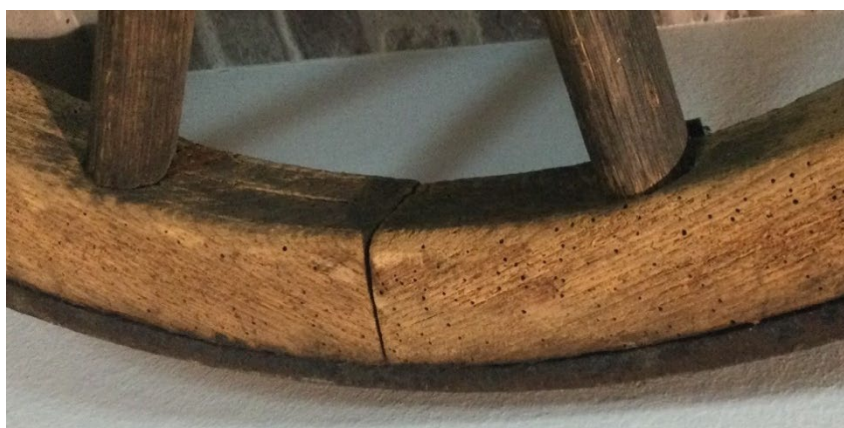
56 Wagenrad (Segment): An diesem kleinen Ausschnitt eines alten, wurmstichigen Wagenrades lässt sich erkennen, wie die vom Metallreif zusammengehaltenen und ausgesägten, nicht in ihrer Biegung gewachsenen Holzteile stabilisiert werden. (Foto: Verfasser)
