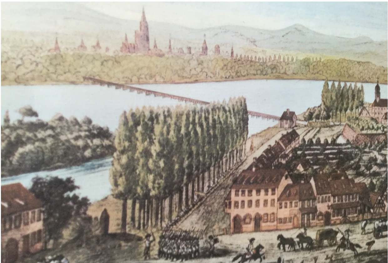
173 Kehl mit „Blick hinüber“: Eine seltene Sicht von Kehl und Strasbourg, leider ohne Angabe eines Autors. (Quelle: Bibliothek des historischen Vereins Mittelbaden in Kork) Wie der Holztransport in den Vogesen ablief, verdeutlicht der folgende kolorierte Holzschnitt (kein Verfasser, Privatbesitz).
