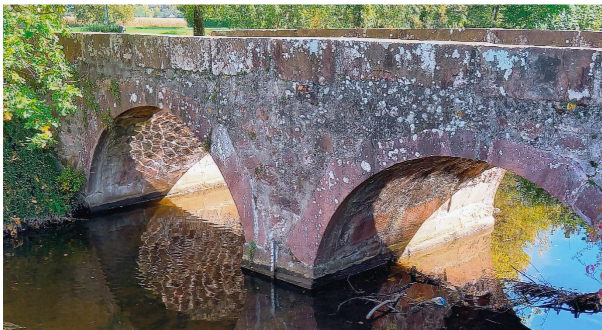
118 Steinbrücke: Diese recht unscheinbare Brücke befindet sich in Dinglingen, einst selbständig, doch längst eingemeindet in die Stadt Lahr. Sie überbrückte lange Zeit die Schutter. Diese wiederum führt vorbei am einstigen Kloster Schuttern (gegr. 604) und mündet schließlich in die Kinzig. Diese mündet in Sichtweite des nicht nur holzhungrigen Straßburgs in den Rhein. Dass die Schutter beflößt wurde, darf man aus rein sachlichen Gründen getrost festhalten. Da sich in diesem Dinglingen ein römischer Vicus befand – seit einigen Jahren ist dort ein Streifenhaus exemplarisch wiedererstellt und zugänglich. Die damaligen fünf Brennöfen werden kaum nur für den örtlichen bedarf Tonwaren gefertigt haben. Straßburg als Absatzmarkt liegt nahe, eventuell auch Brumath, die dazugehörige Siedlung (Foto: Verfasser)
