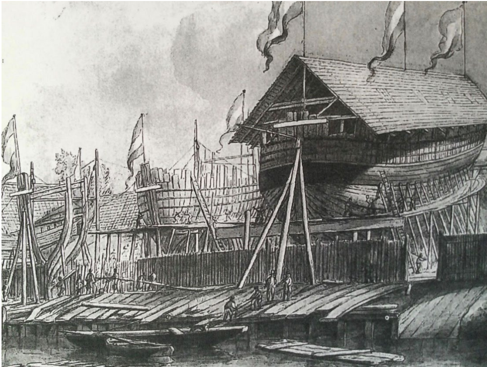
214 b Dordrecht – Schiffswert um 1850: In der Darstellung von 214 a ist gut nachvollziehbar, wie das fertige Schiff ins Wasser kam; in 214 b dürfte die Tide die entscheidende Bedeutung gehabt haben. (Quelle übernommen von Dr. Max Scheifele)
